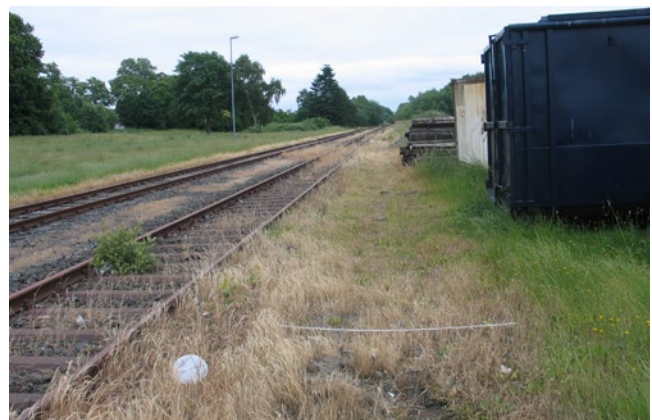
Abb. 6 Beispiel für eine unsachgemäße Anwendung von Pflanzenschutzmitteln auf Gleisanlagen (Quelle: Pflanzenschutzdienst Bremen)
